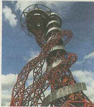
La tour atteint 114,5 m de haut.
